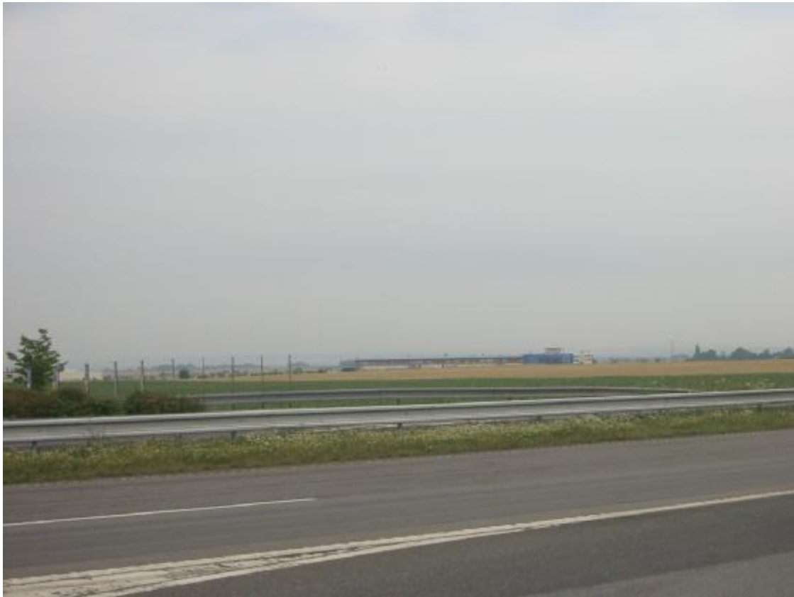
Foto č. 1 – Pohled na areál Logistického Centra Diskont Plus od jihu, z komunikace R10
