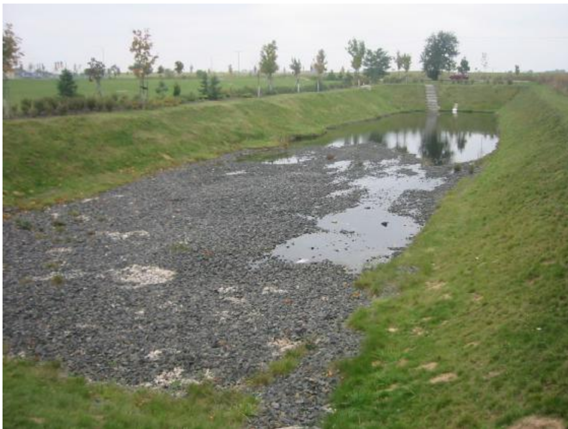
Foto 4: současná retenční nádrž, která slouží pro zachycení přívalových dešťů
