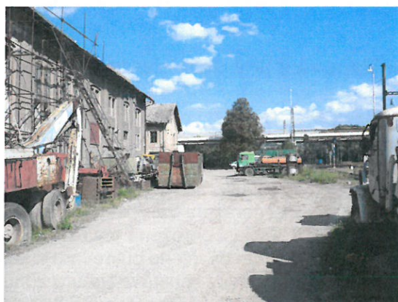
Pohled ke komunikaci Beroun - Koněprusy
