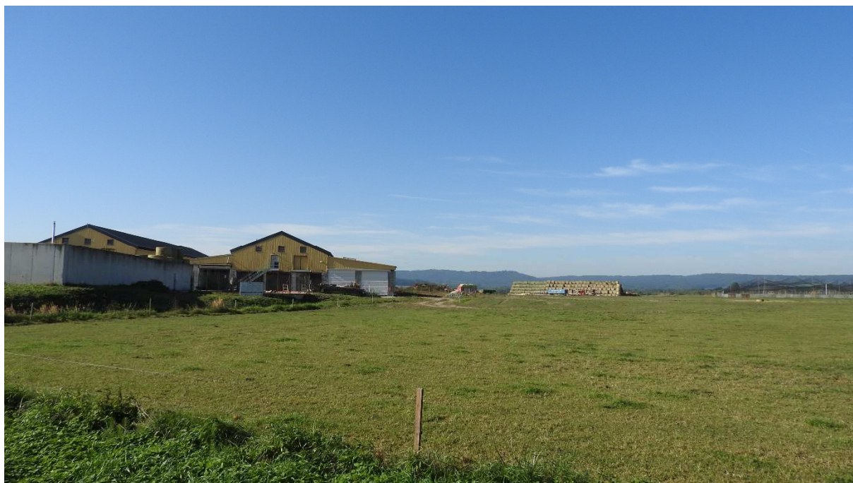
Pohled na prostor určený pro stavbu stáje (Foto Lukáš Klouda)
