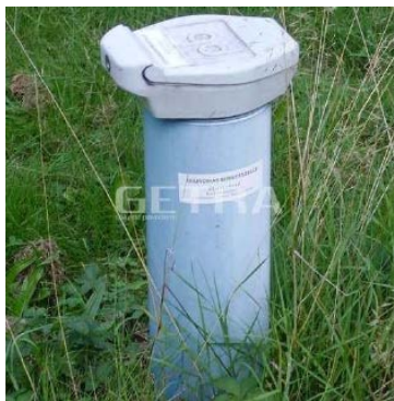
Obrázek č. 20: Záhlaví nového monitorovacího vrtu
