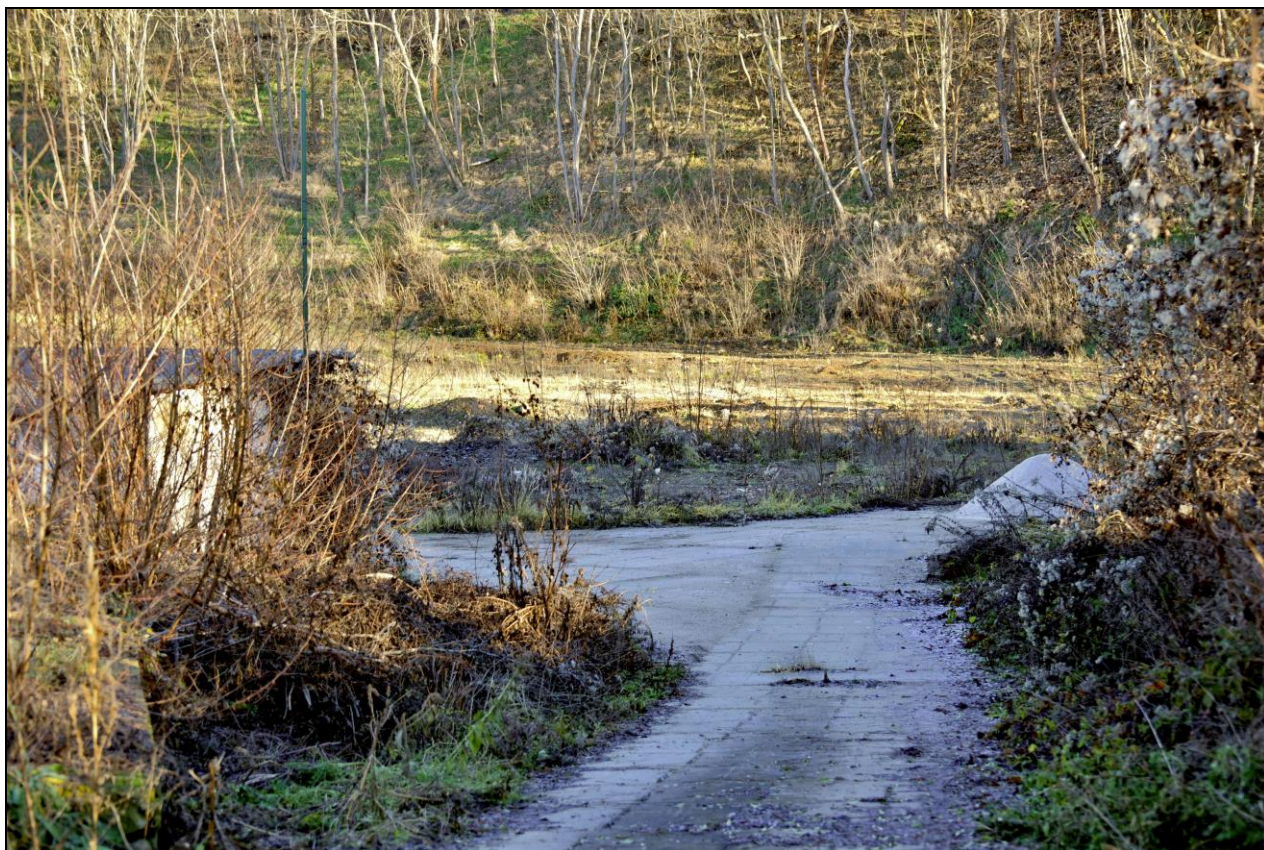
Sjezd na upravovanou plochu (pohled od západu, od příjezdu na plochu)
