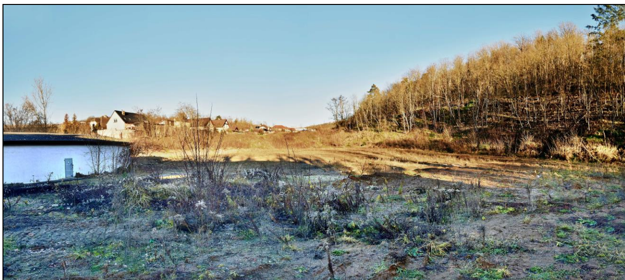
Celkový pohled na upravovanou plochu (od sjezdu)
