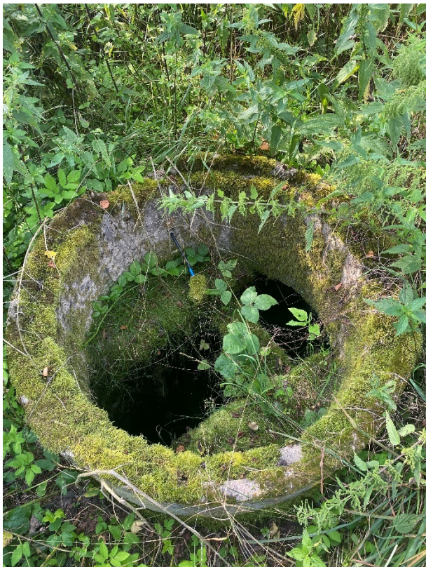
Obrázek č. 8 Stávající kopaná studna
