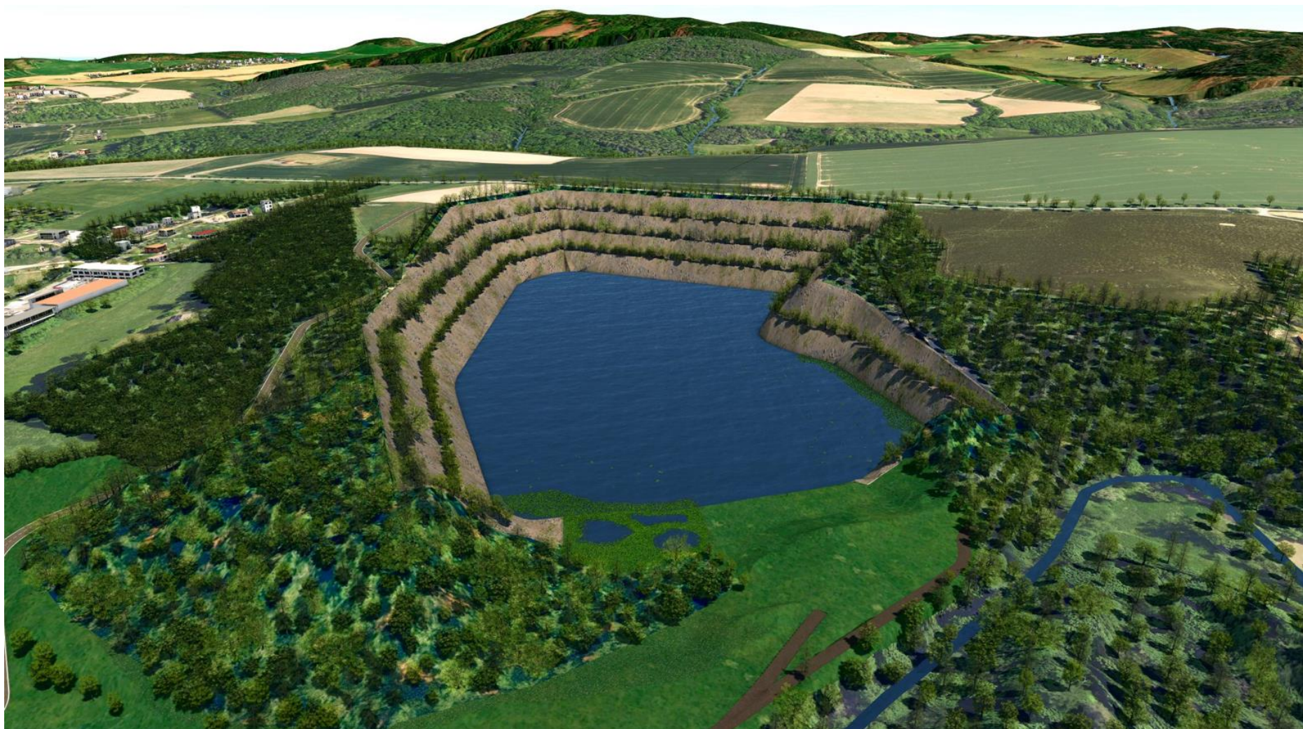
Pohled z výšky od jihu (nad železniční tratí)
