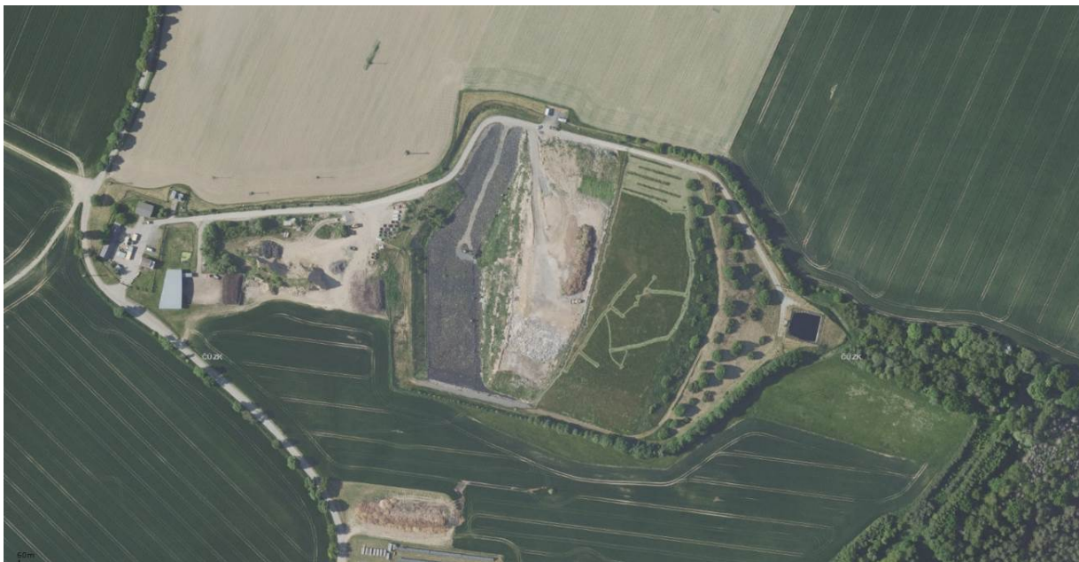
Areál skládky, v pravé části dobře viditelná jímka výluhových vod. Zdroj: mapy.nature.cz
