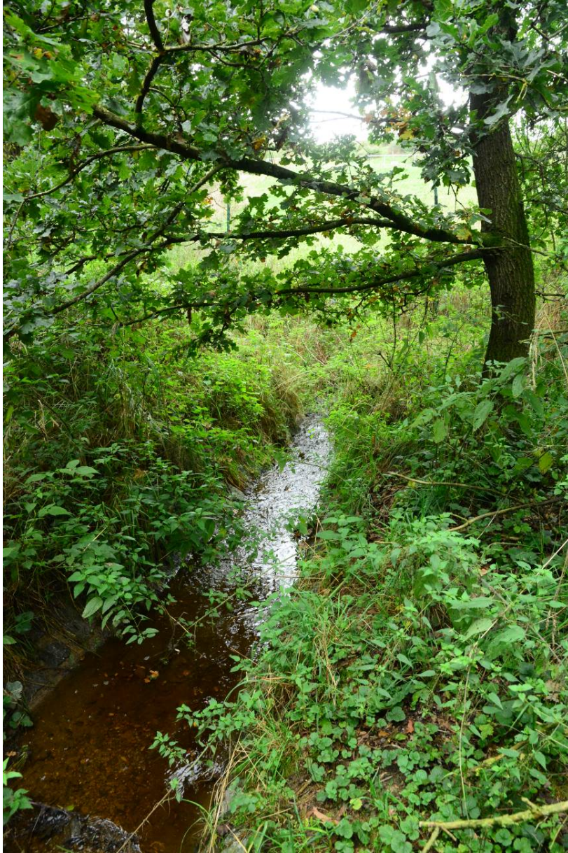
V úseku těsně pod skládkou má tok narovnané zpevněné koryto, níže pak již opevnění chybí.
