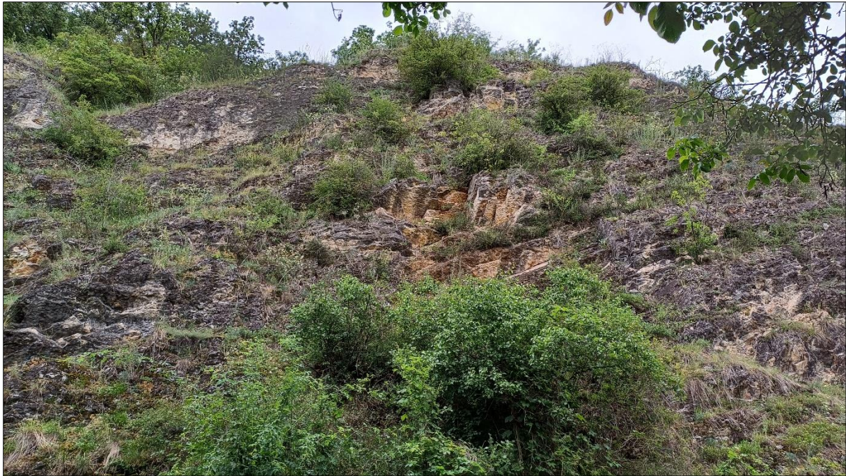
Obr. 21: Lokalita 8-, odstraněny budou bloky zjevně postižené puklinovým systémem o rozloze 36 m 2
