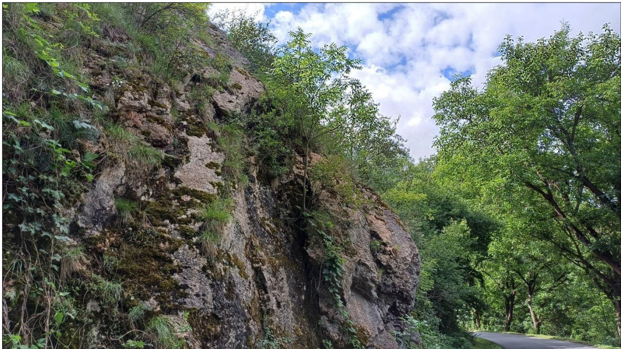
Obr. 16: Lokalita 1, odstraněny budou bloky zjevně postižené puklinovým systémem o rozloze 72 m 2
