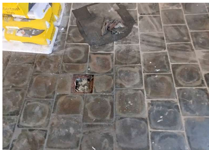
Foto 7: Pohled na podlahovou vpusť podzemní záchytné jímky v dílně
