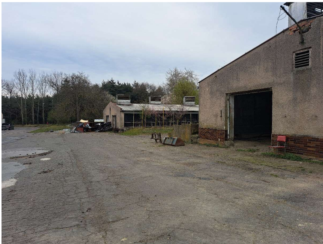
Pohled na prostor určený pro stavbu hal H1 a H2
