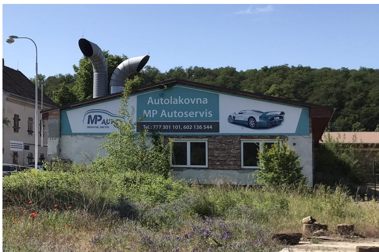
Obrázek 10 - Lakovna s umístěným sáním a výdechem VZT nad střechou – stávající stav
