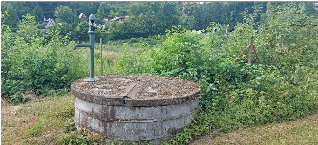
foto 4: Stará studna na pozemku 1617/1. Od pozemku záměru je vzdálená 9 m. Není nijak označená, nemá ochranné pásmo a není ani zabezpečená proti vnikání nečistot (viz mezera mezi polokruhovými uzávěry). Nepodařilo se dohledat na příslušném vodoprávním úřadu údaje k tomuto objektu. (červenec 2025, GV)
