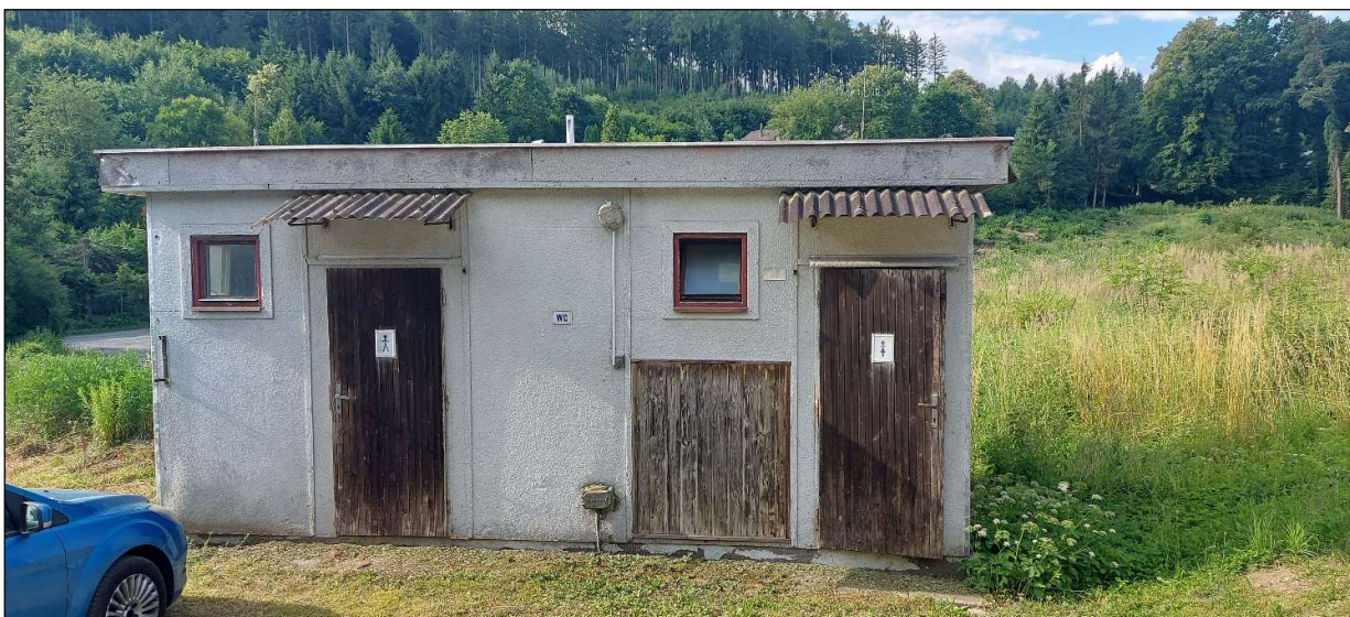
foto 5: 30 m od studny jsou staré záchody, v současné době nepřístupné. Není tedy možné zjistit, zda jsou suché nebo zda jsou napojeny na nějakou jímku.
