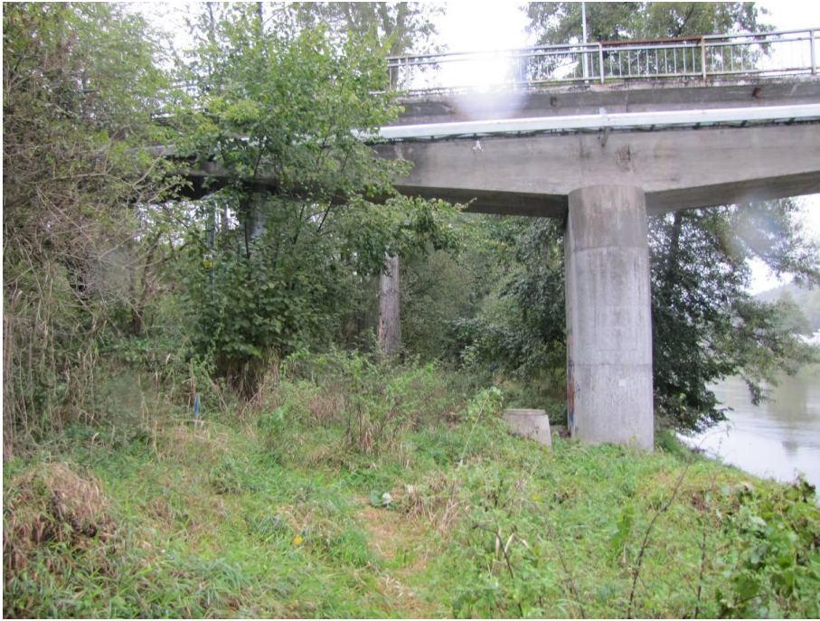
Obr. 6: Pohled na pozemky v okolí lávky
