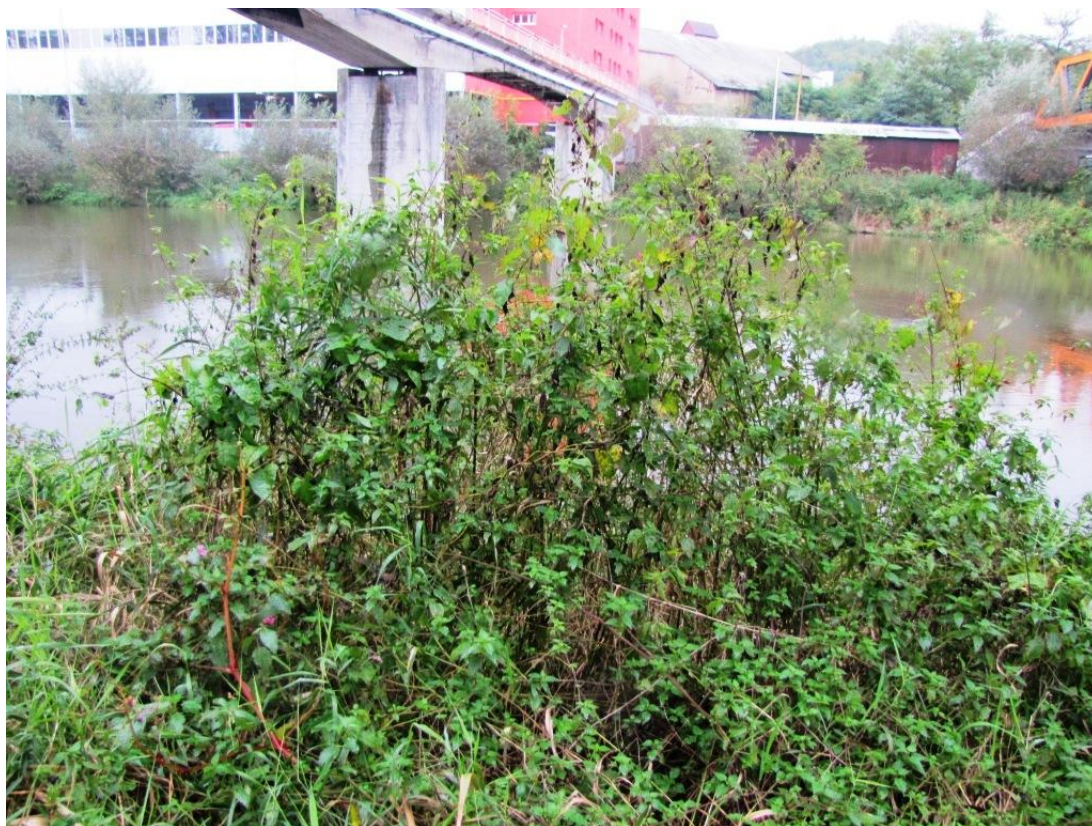
Obr. 1: Pohled na lávku a její okolí
