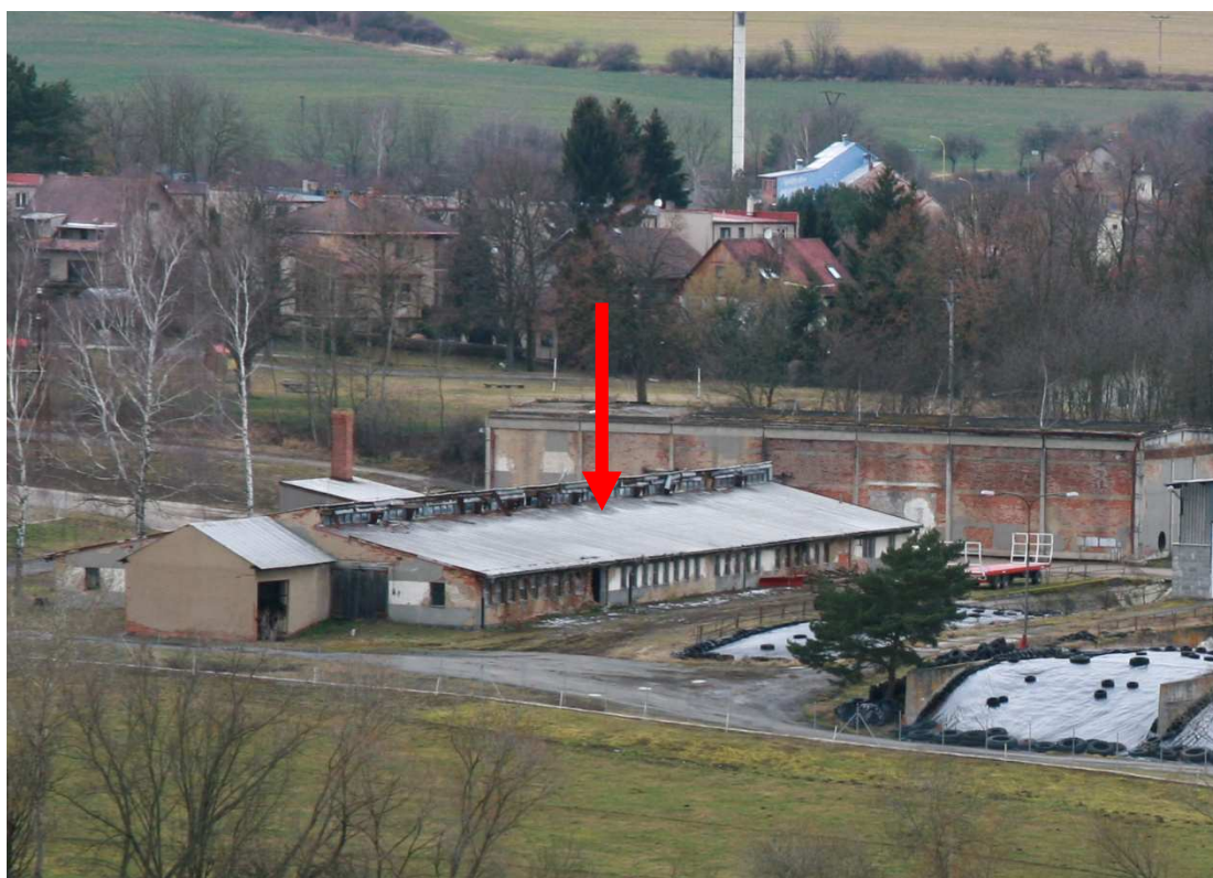
Stáj určená k rekonstrukci SO-02
