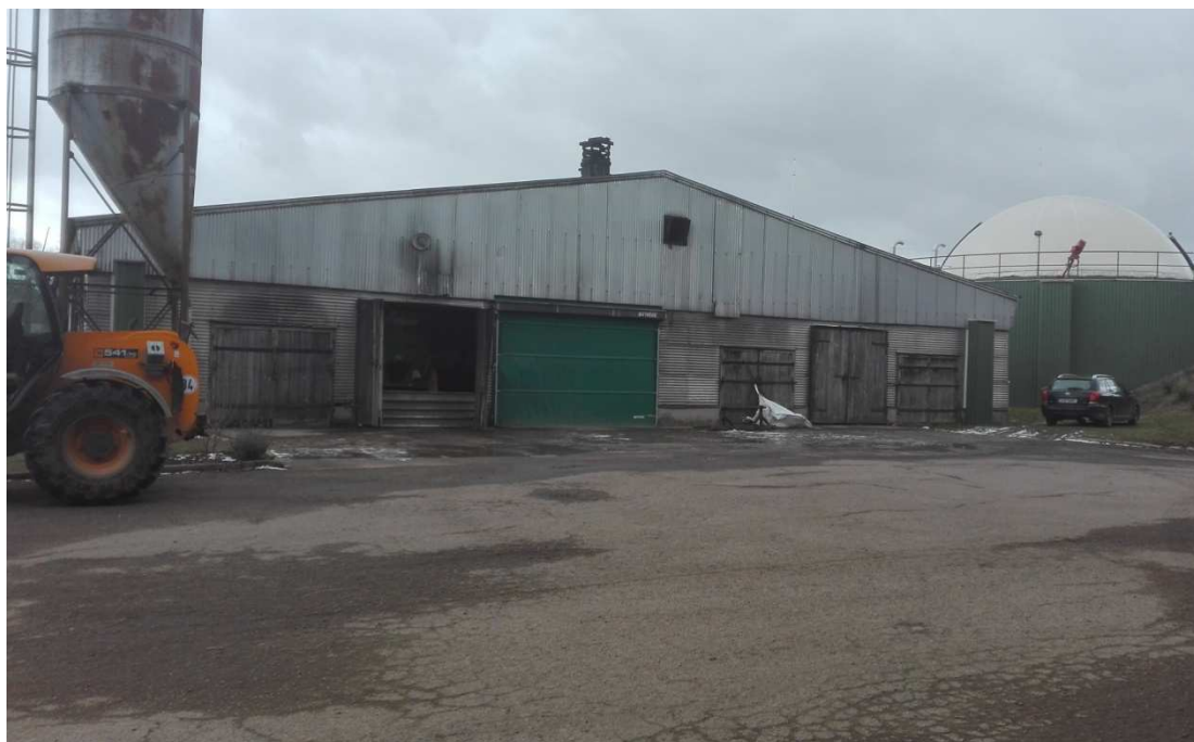
Stáj určená k rekonstrukci SO-01
