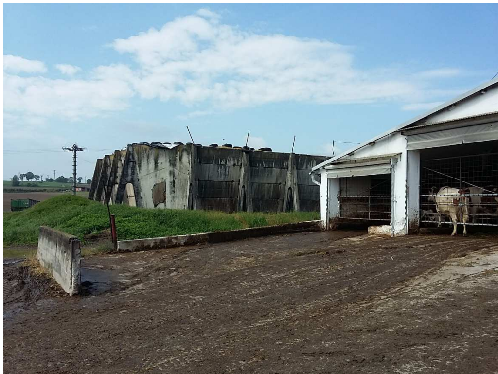
Žlab a stáj určené k demolici
