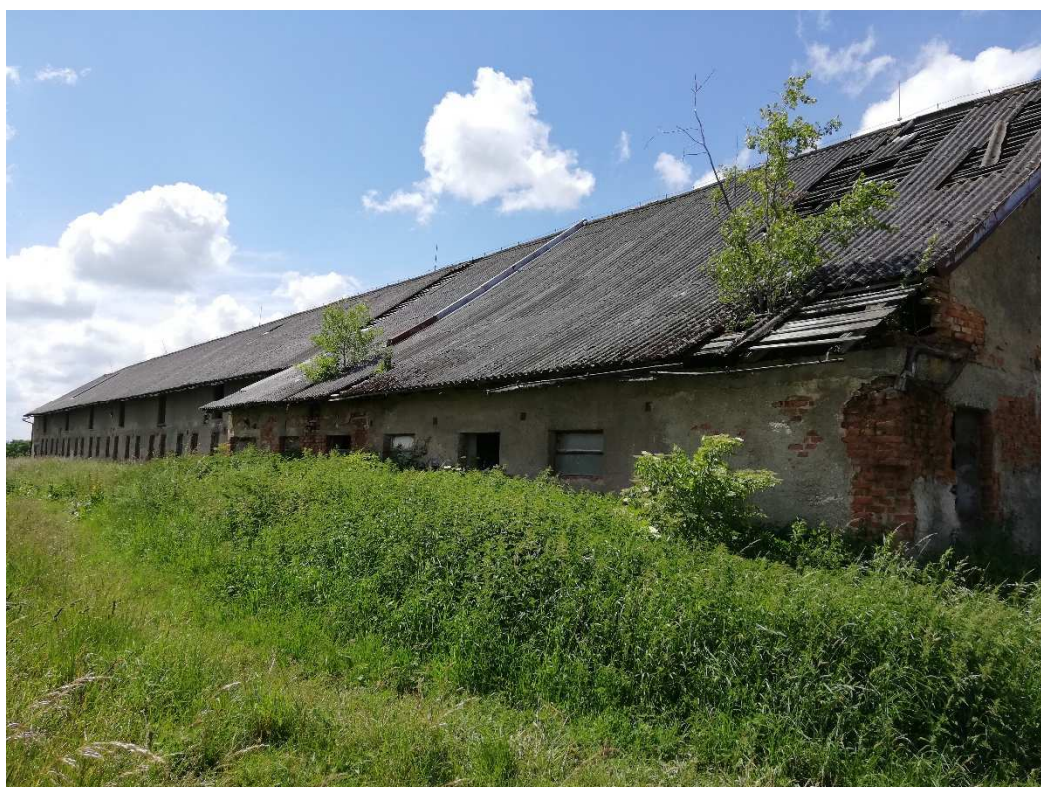
Pohled na stáj určenou k demolici
