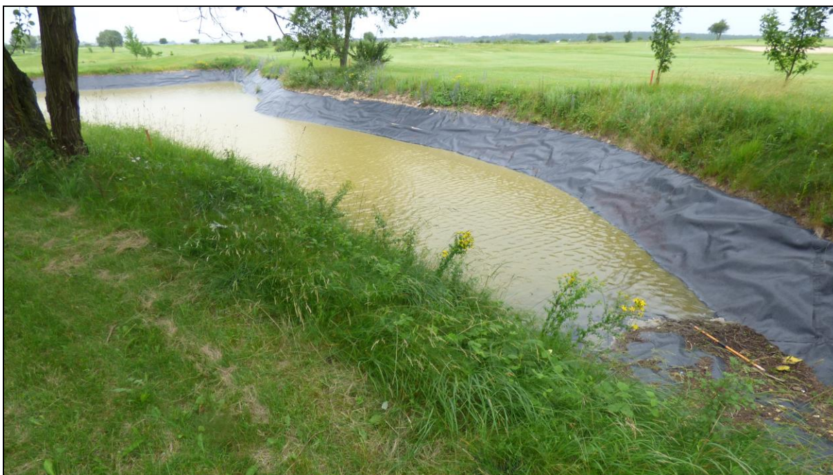
Akumulační nádrž č. 2 (horní) pro akumulaci vyčištěných a srážkových vod s následným využitím pro závlahu travnatých ploch golfového areálu
