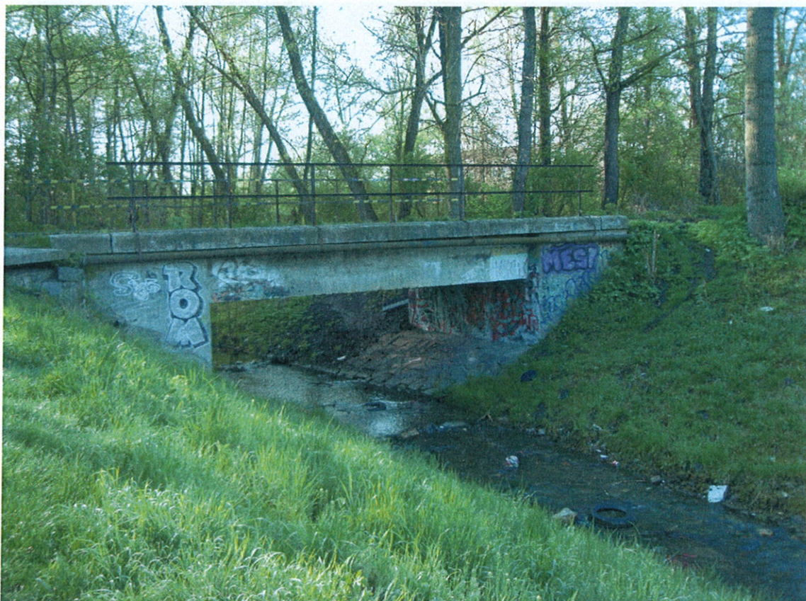
Pohled na železniční most přes Pšovku na stávající vlečce.
