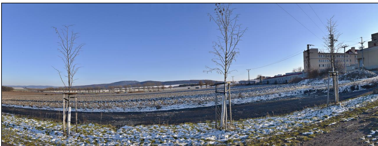
Pohled na stavební lokalitu U nemocnice (od západu)
