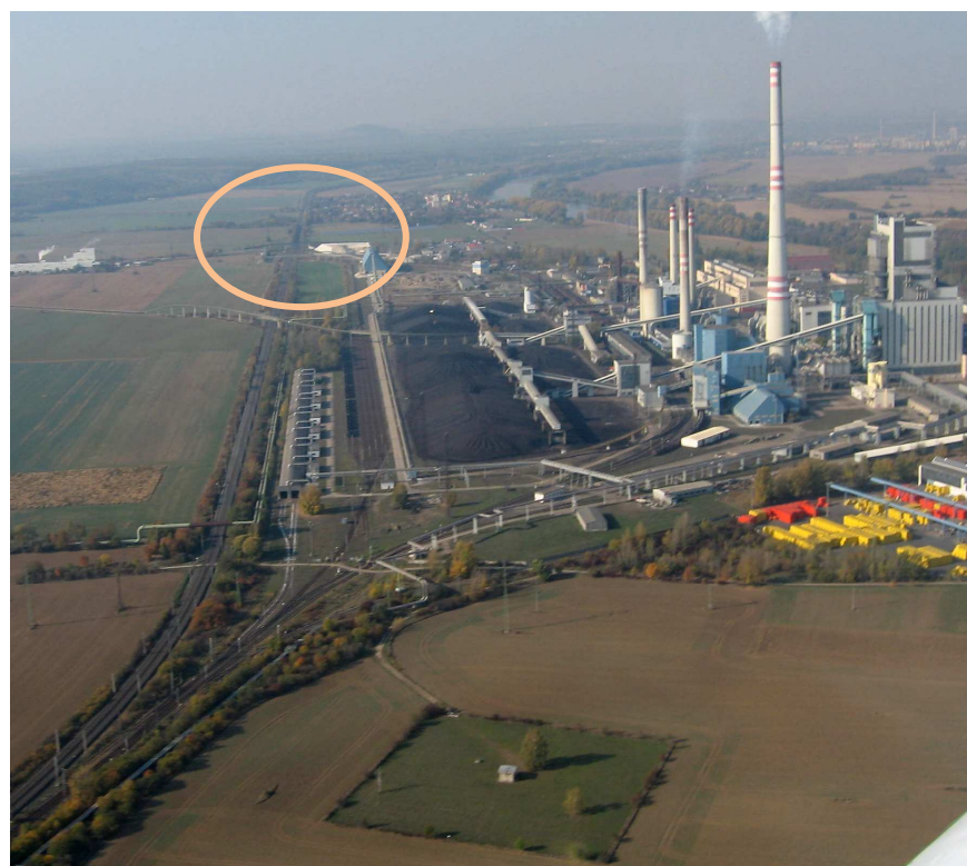
území pro budoucí komunikaci Z od EME, napojení na ZEVO a na areál RIGIPS
