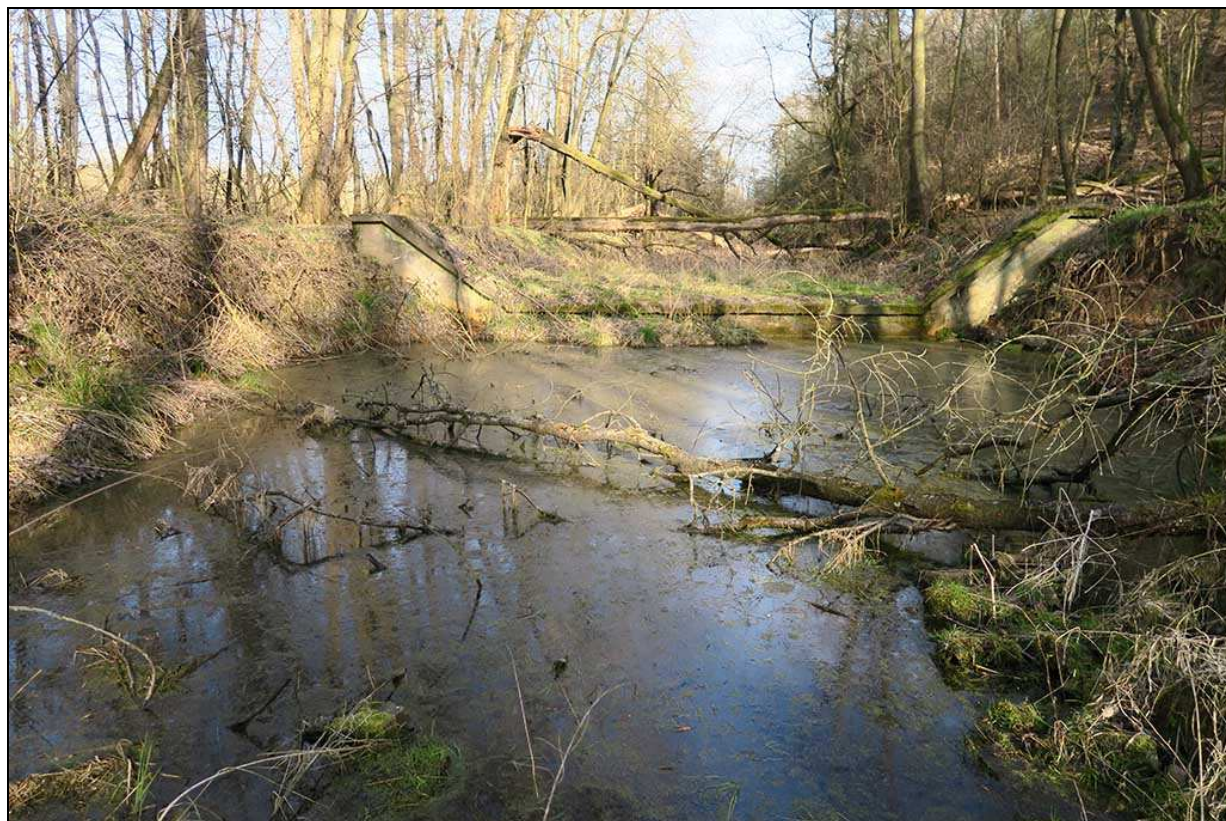
Obrázek 57: Odpadní kanál pod bezpečnostním přelivem pod hrází (5. 4. 2020).
