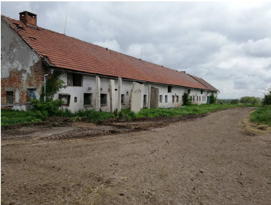
Pohled na stáj určenou k demolici (místo pro novou jímku)
