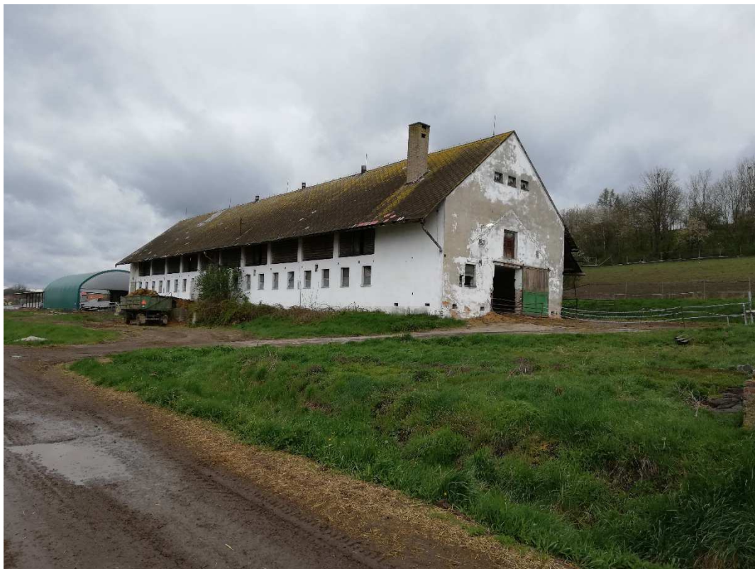
Pohled na stávající porodnu určenou k demolici
