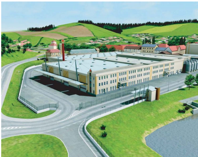
pohled od SZ na skladový a expediční komplex v severní části areálu pivovaru (v popředí vjezd do areálu, Velký rybník a nová vrátnice, v pozadí stará část pivovaru a obec Krušovice)
