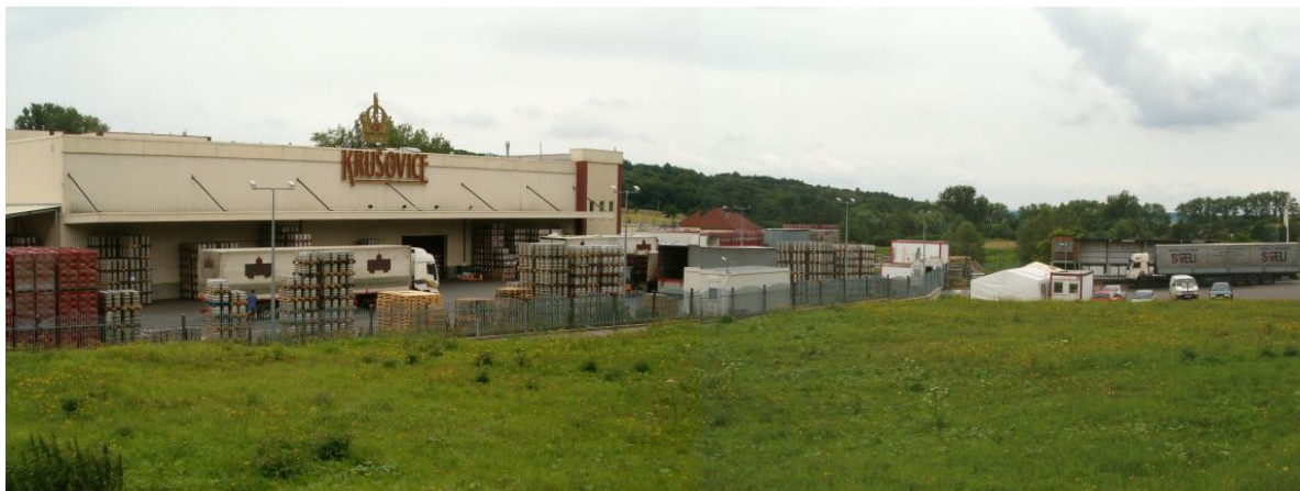
Pohled na stáčírnu a expediční sklad od silnice I/6 (od S). Vpravo hlavní vjezd do areálu pivovaru, v pozadí objekt ČOV pivovaru. Skladování přepravek, obalů, sudů a palet na volném prostranství před objektem stáčírny a expedičního skladu
