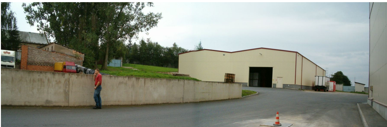
Stávající skladová hala, situovaná jižně od areálu ČOV pivovaru, přístavba je projektována doleva (do svahu), vpravo objekt nové varny
