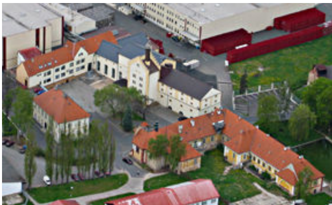
Pohled na centrální, historickou část pivovaru – tzv. nádvoří a Fürstenberský zámek (v popředí), vpravo v pozadí stávající objekt stáčírny a expedičního skladu
