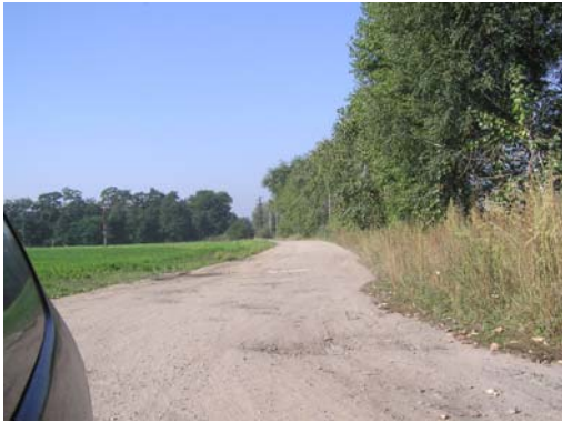
příjezdová komunikace k silnici č. 272
