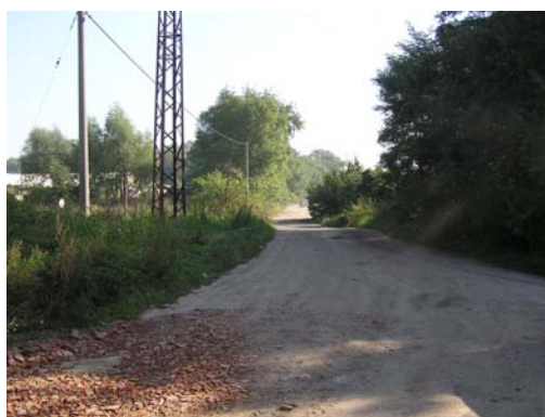
příjezdová komunikace k silnici č. 272
