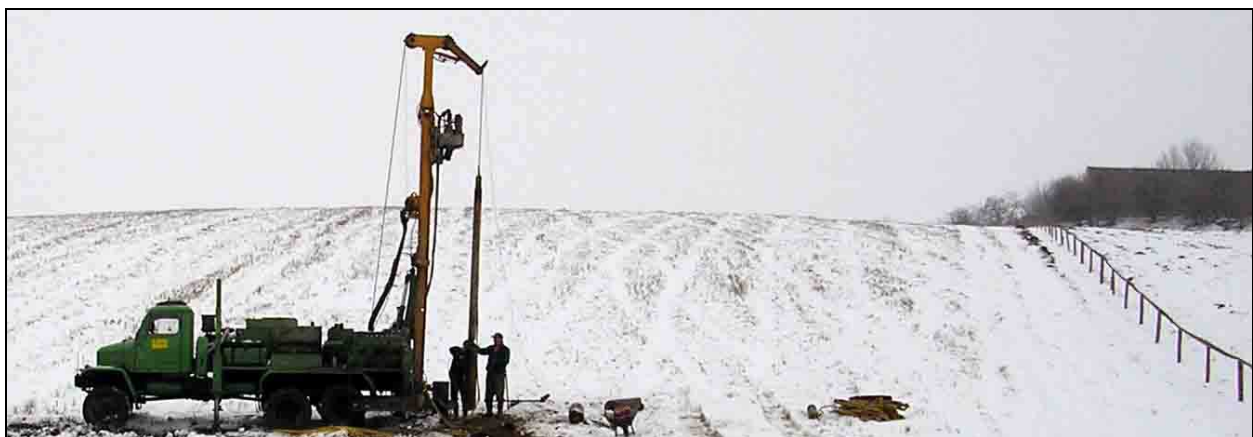
Obr.č.22. Hydrogeologický průzkumný vrt pro ověření vydatnosti podzemního zdroje vody - vrt PV-5 umístěný v lokalitě B znázorněné v příloze č. F.4.
