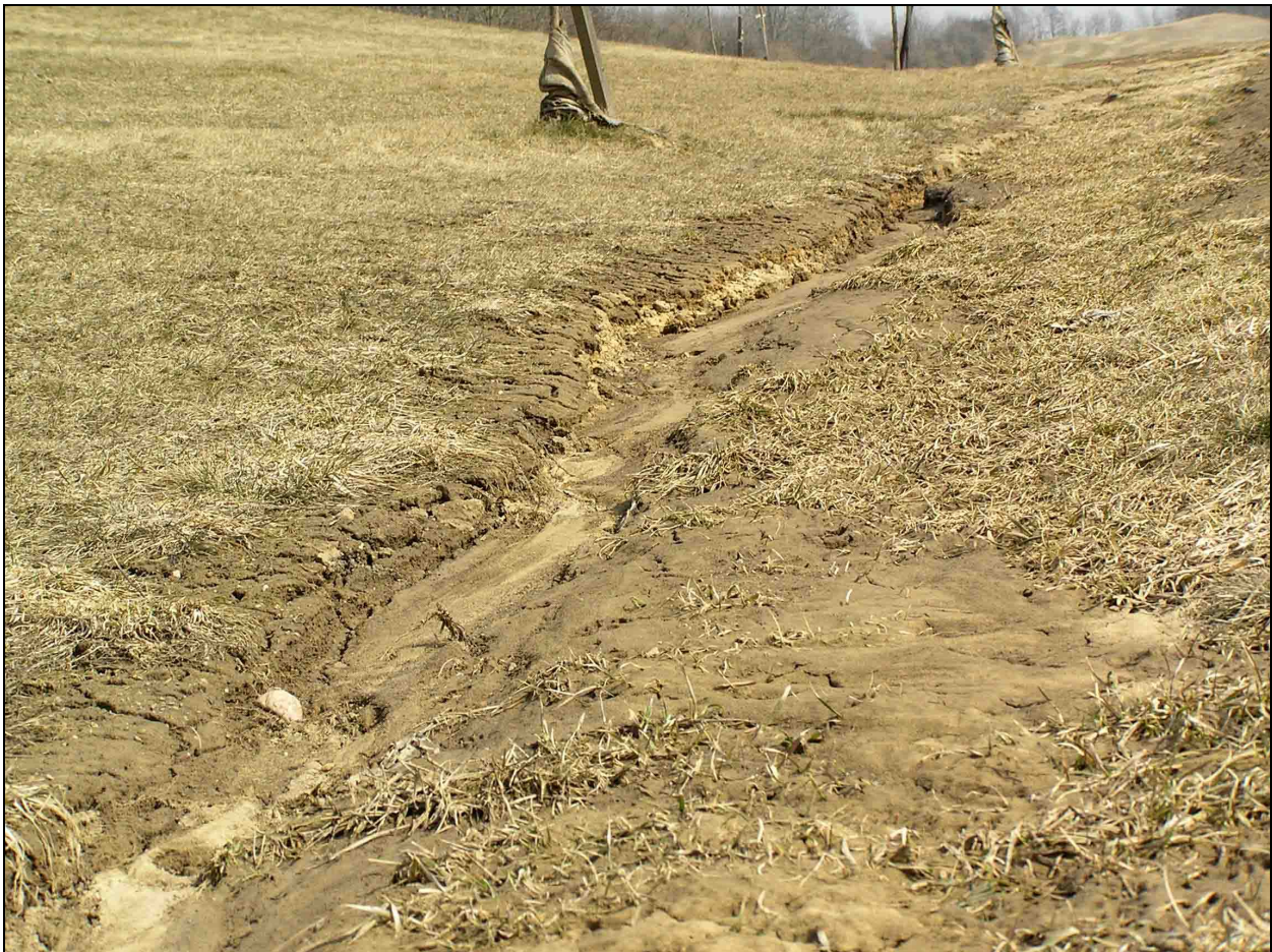
Obr.č.19. Rýžková eroze na současném GOLFU - místo eroze viz Obr.č.15, B
