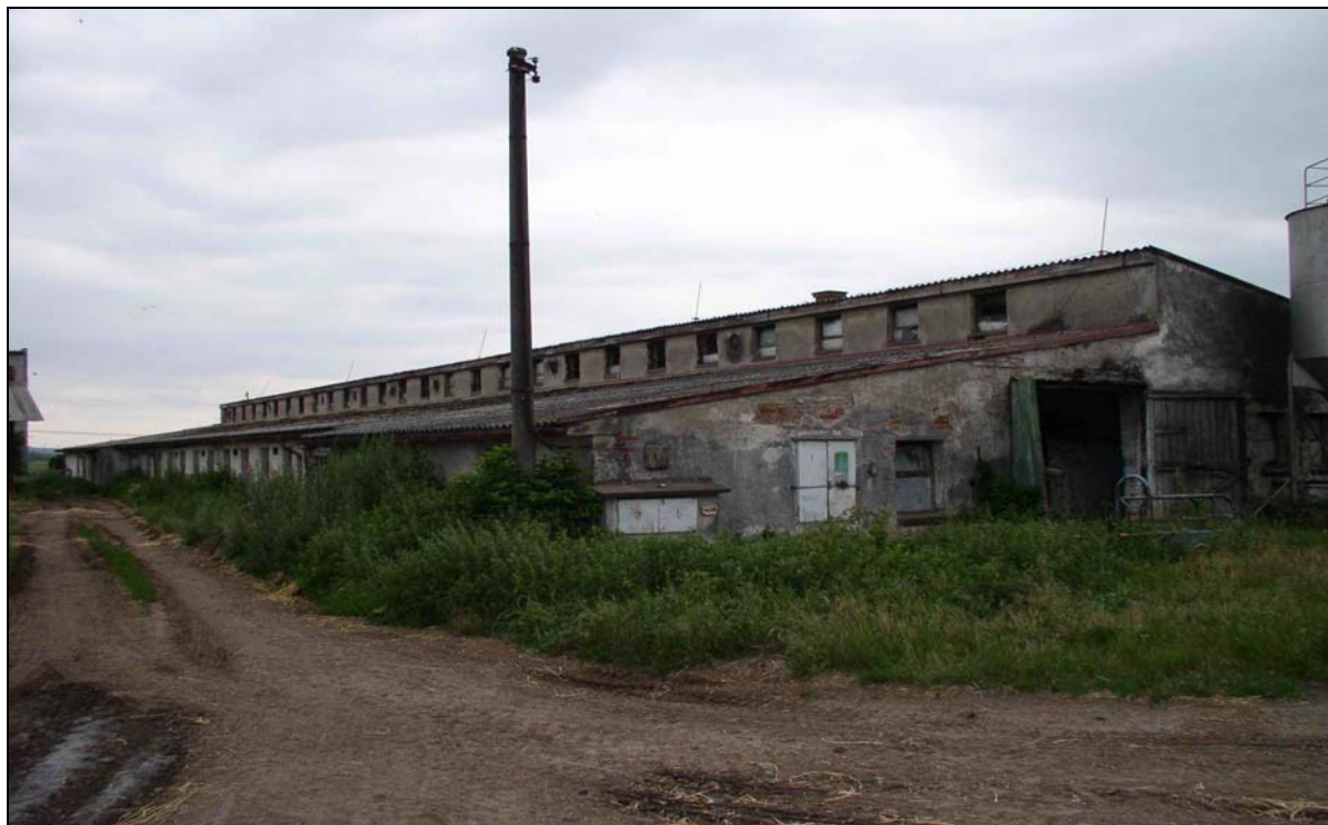
Obr. č. 4: Stáj K 174/7 k rekonstrukci
