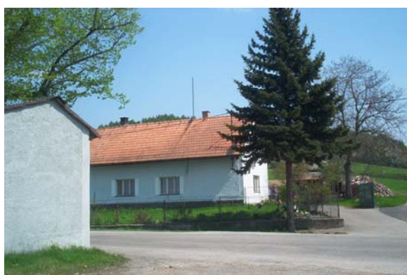
dům č.p. 31 na křižovatce silnice Konopiště - Neveklov - Tisem
