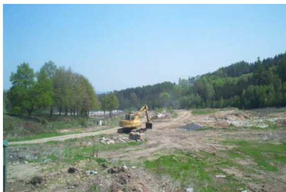
pohled od záměru na část skládky Příbyšice
