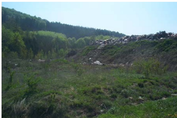
těleso skládky - ochranný val v údolí (směrem na Vatěkov)
