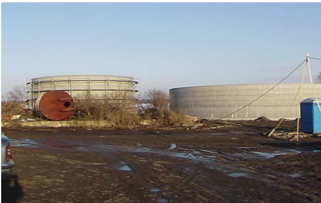
Obr. 6 Fermentační nádrže – vlevo metanizační před izolačními pracemi, vpravo druhý stupeň – vyrovnávací a dokončující fermentaci.
