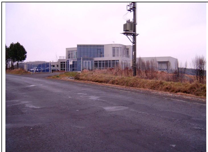
Obr. č. 12. Areál firmy WAVEX, spol. s r.o. u silnice II/110 a plocha betonárky za silnicí II/113
