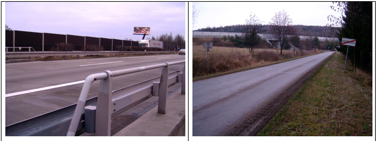
Obr. č. 19. Protihluková stěna na dálnici D 1 u obce Ostředek
