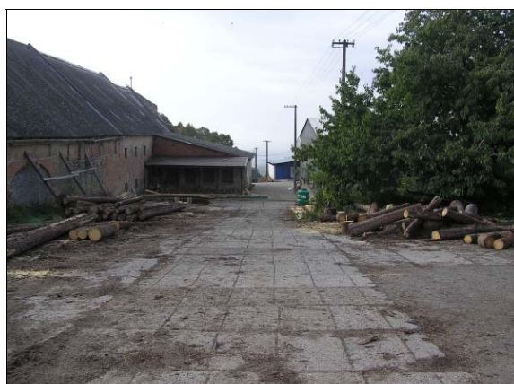
Příjezdová komunikace k areálu BPS
