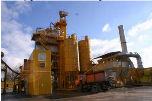
Věž a zásobníky na filer
