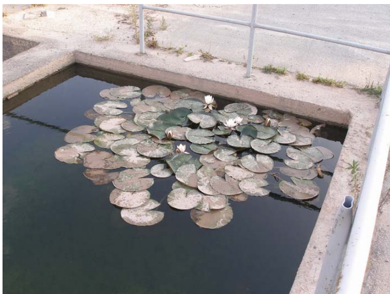
Stávající požární nádrž v areálu (voda v ní není provozem obalovny nijak znečištěna)
