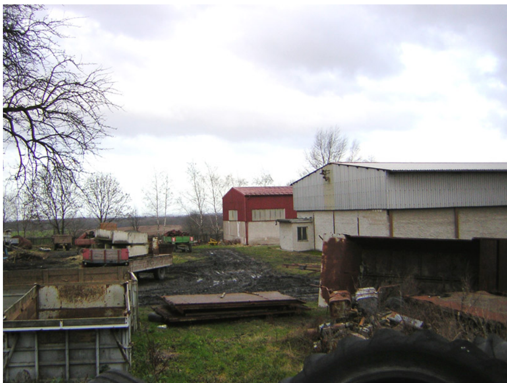
Pohled od hlavního vjezdu
