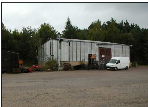
Stávající objekt, který bude využíván jako sklad
