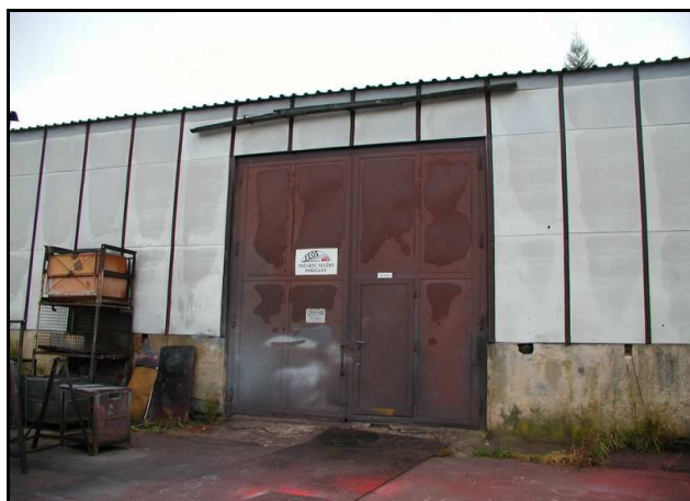
Stávající objekt, který bude využíván jako sklad
