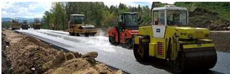
zařízení staveniště pro dálnici
