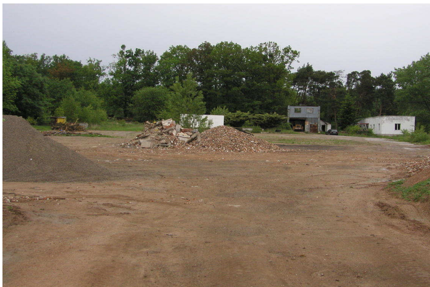
Plocha pro recyklaci, vzadu provozní budova
