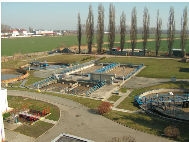
Vlevo vzadu kruhová usazovací a dosazovací nádrž, vlevo v předu zahušťovací jímka, ve středu de/nitrifikační nádrže, vpravo kruhová dosazovací nádrž
