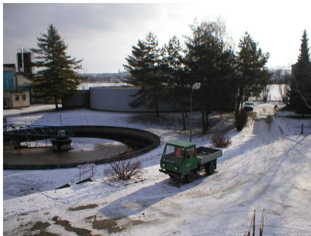
Vpředu dosazovací nádrž, v pozadí uskladňovací nádrž
