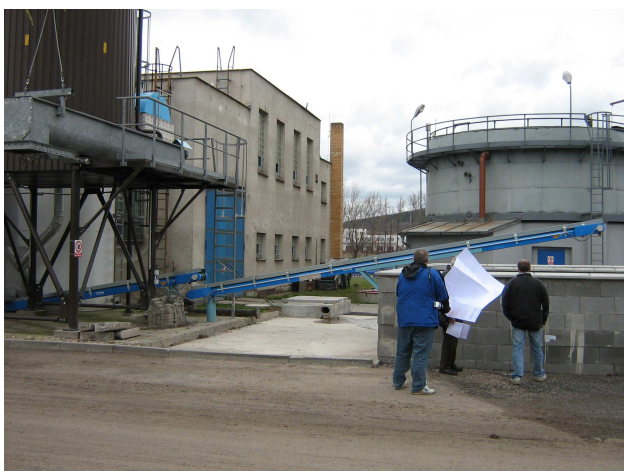
Vlevo budova strojního odvodnění kalu (v současnosti již mimo provoz), vzadu vpravo homogenizační nádrž
