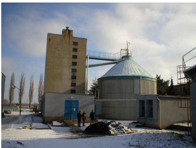
Vyhňivací nádrž s výstupní věží
