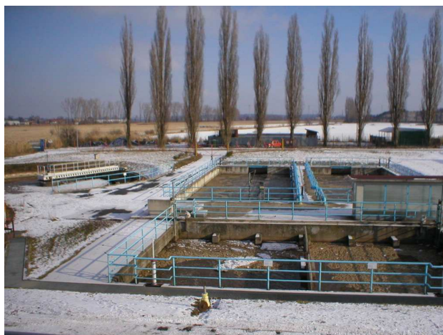
Vpředu denitrifikační sekce, v pozadí navazující nitrifikační nádrže.
