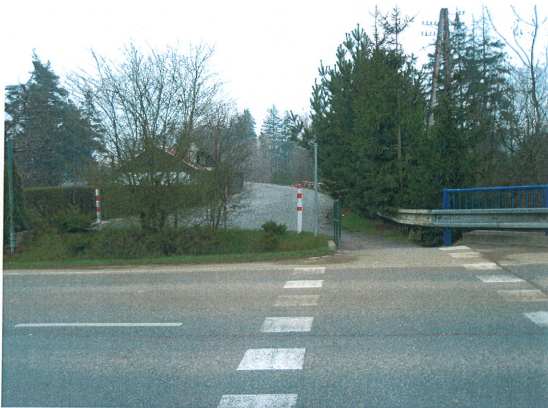
Obr. Pohled na místo budoucího křížení obchvatu se železniční tratí v km 5,45.
