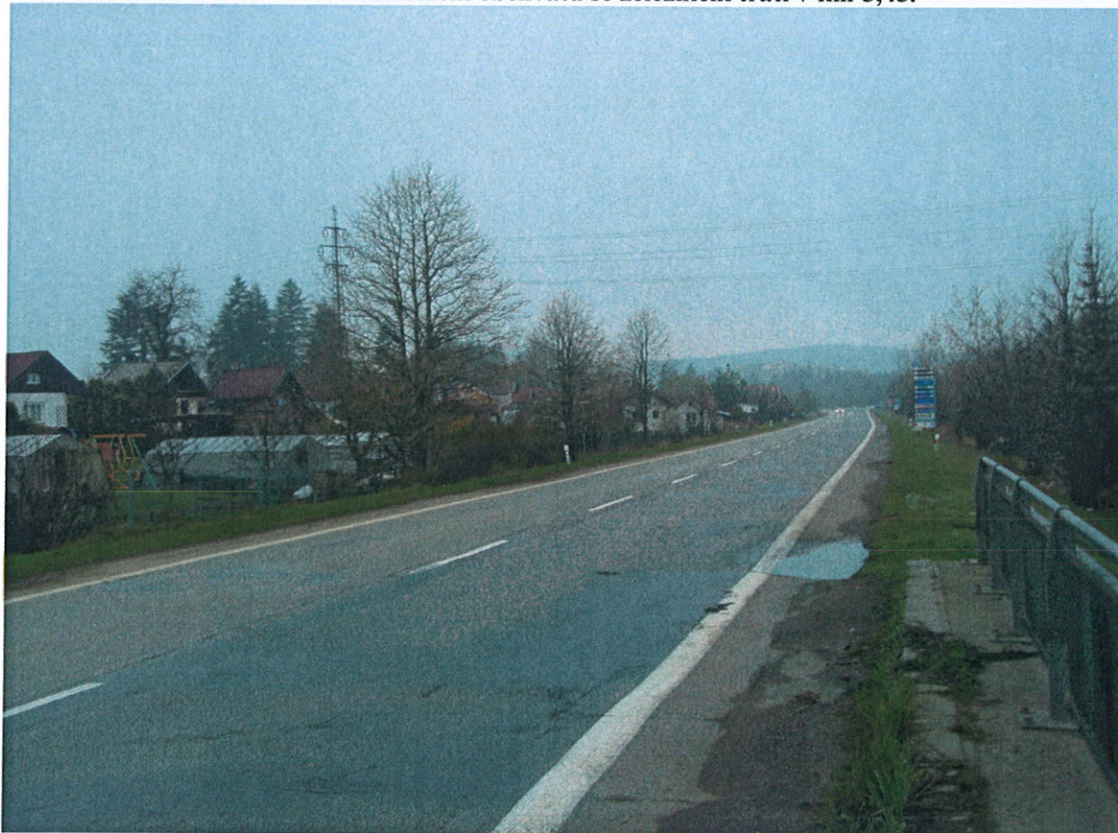
Obr. Pohled ve směru silnice I/66, vlevo chaty v Brodě.
