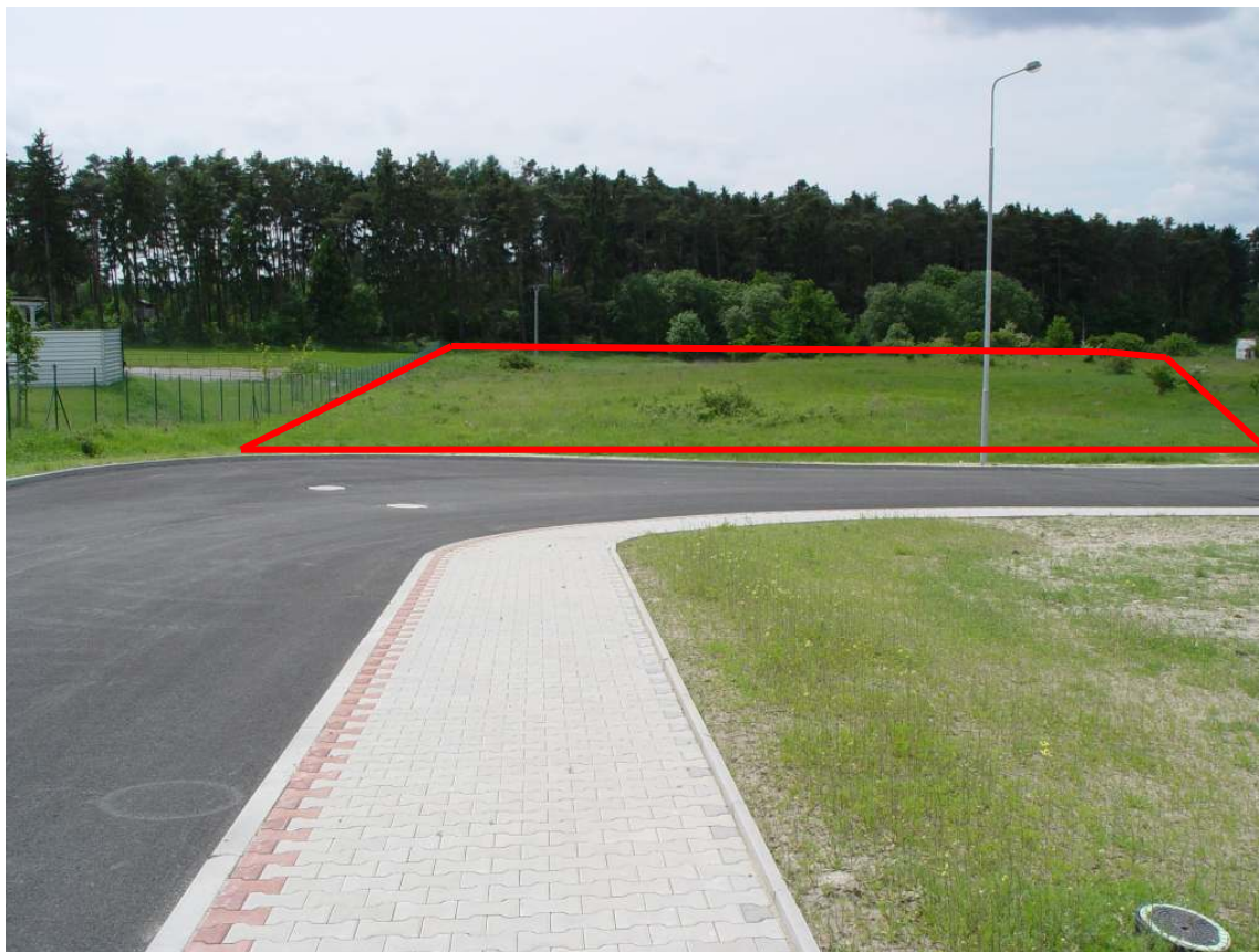
Pohled na staveniště
