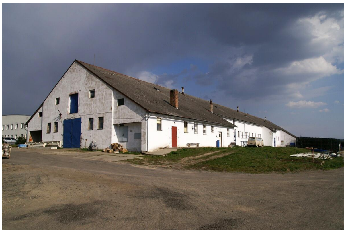
Pohled východním směrem, objekt bývalého kravína
