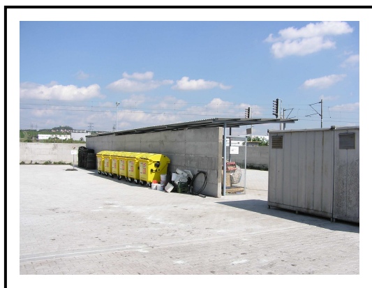
Přístřešek na odpady – druhá strana
