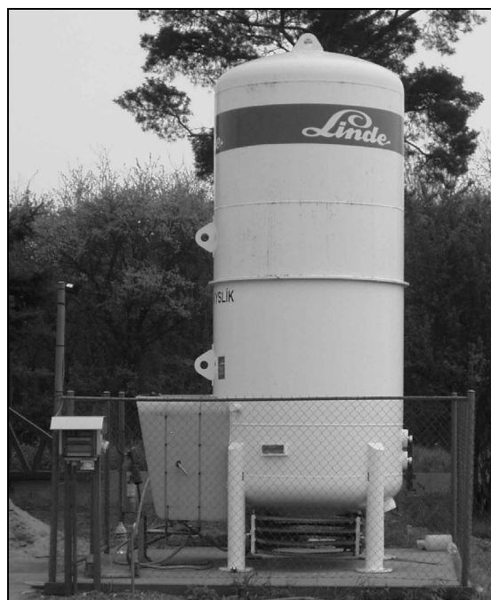
Obrázek 2 – plnicí stanice kapalného kyslíku
