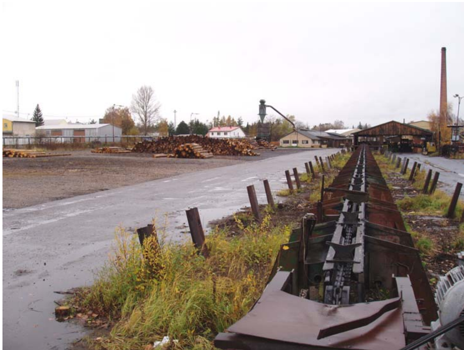
Obr.: Fotodokumentace - Pohled na areál stávajícího závodu od jihu k budoucímu vjezdu
