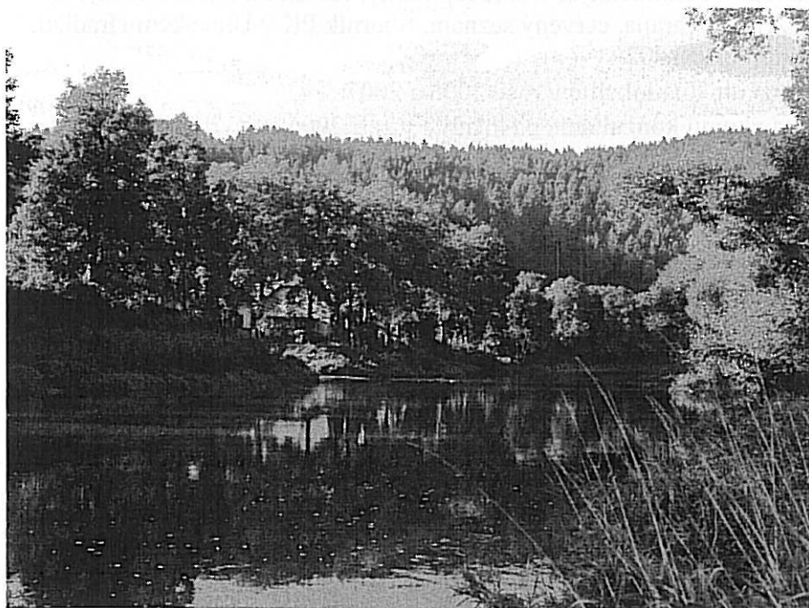
Pohled po proudu Sázavy na ústí Dojetřického potoka. Levý břeh bude zvýšen.
