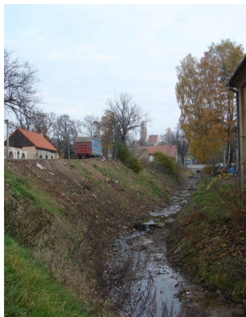
Koryto Krušovického potoka navazuje na severně ležící komunikaci I/6.
