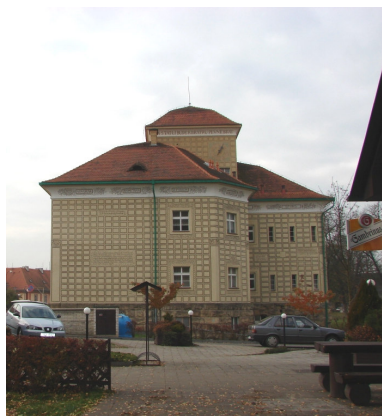
Objekt základní školy v centru obce (pohled ze severovýchodu)
