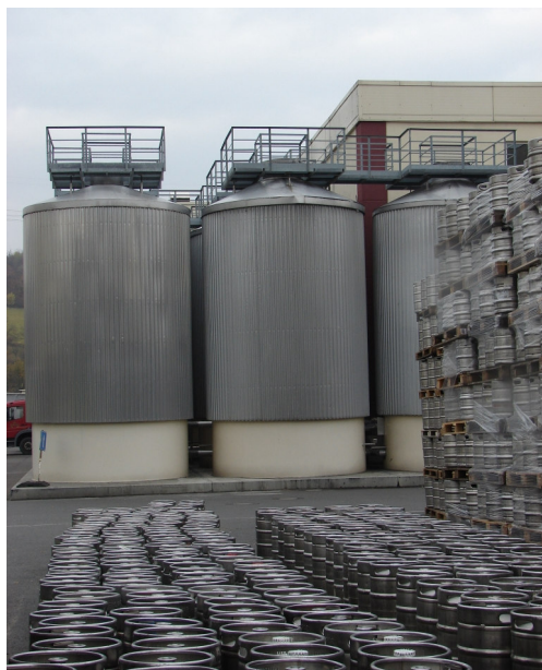
Venkovní přetlačné tanky jsou ze západu situovány v těsné návaznosti na halu lahvárny (budova v pozadí vlevo).
