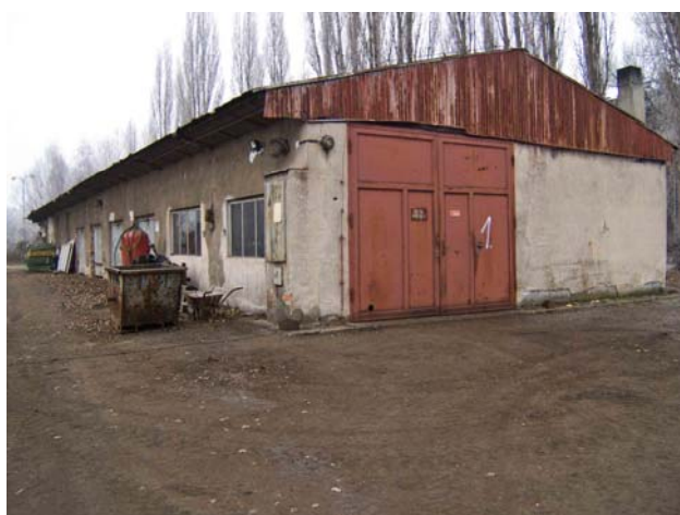
Obrázek 10 – budova skladu a garáží s dílnou
