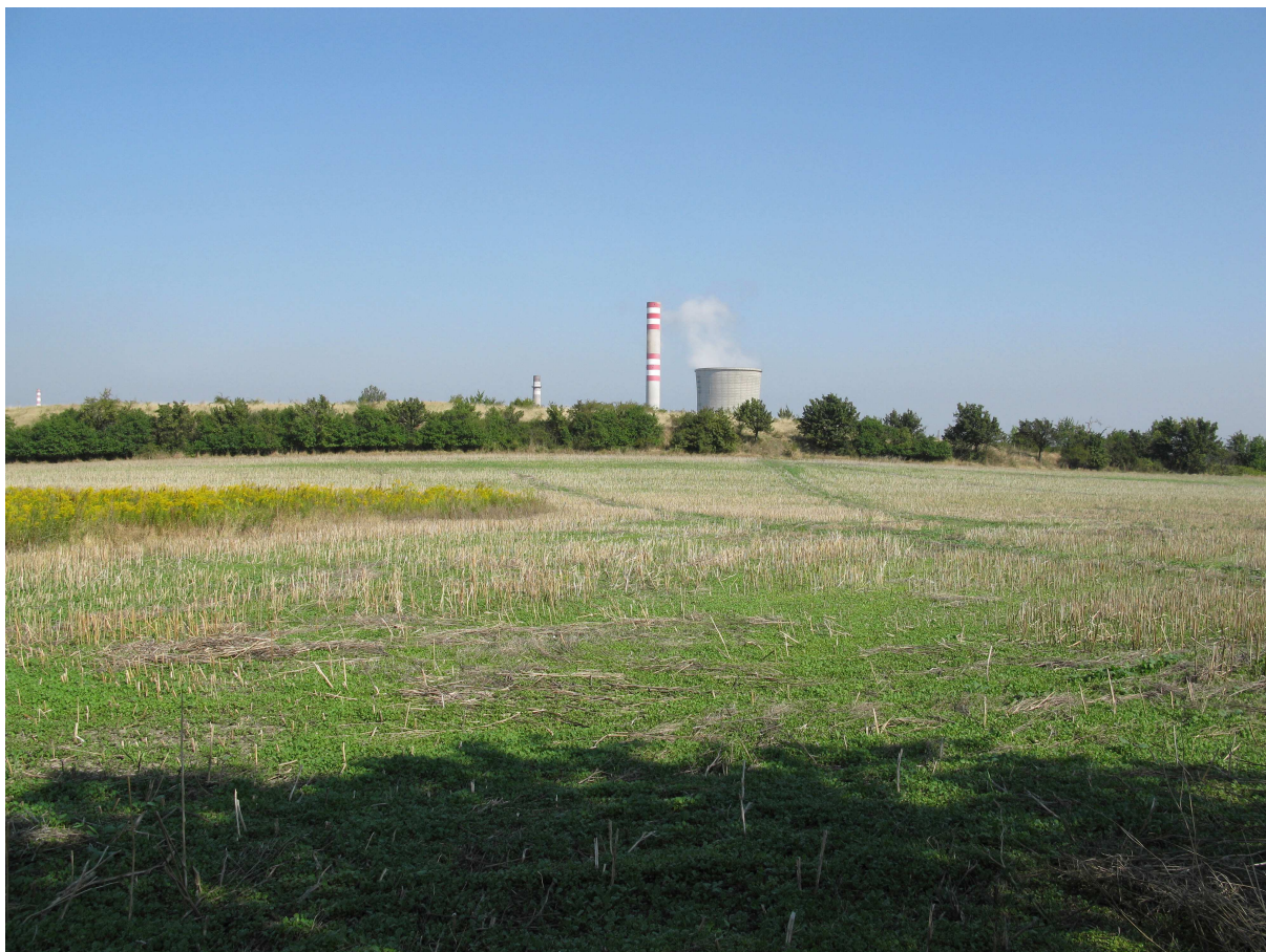
Obrázek č. 1 – Pohled na lokalitu navrženého areálu, srpen 2008
