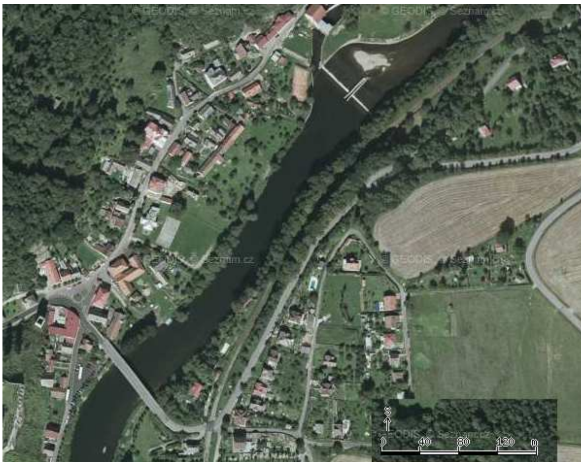
Obr. 2: Letecký snímek Sázavy v Českém Šternberku. Na spodním okraji je vidět most, který má být rekonstruován. Na horním okraji jez, pod kterým byla přítomnost velevrubů zjištěna.
