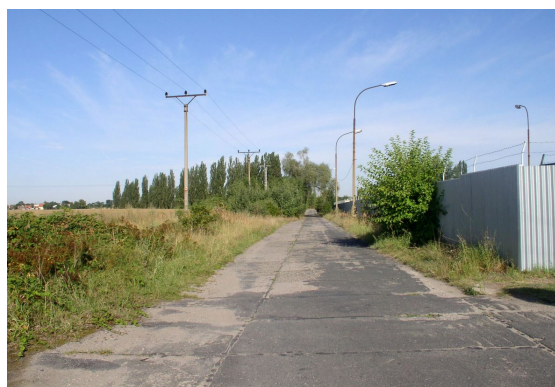
Místní komunikace podél areálu kasáren. V pozadí alej topolů.. Pohled na západ.
